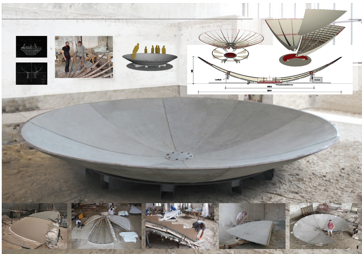
Fig. 20 Die Abbildung zeigt einen Überblick über die Herstellung einer parabolischen Betonschale in Sandwichbauweise.
